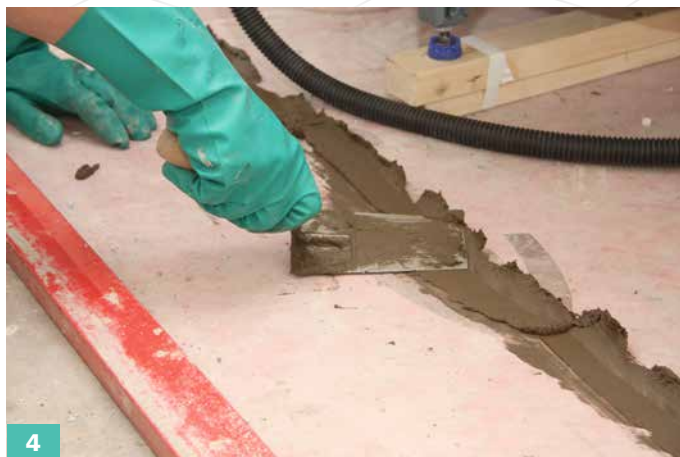
4 ... als auch den angrenzenden Bodenbereich ...
