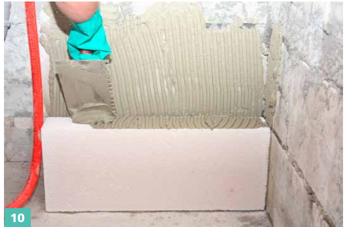
Den Kleber grundsätzlich auf alle angrenzenden Flächen (auch die Seiten) auftragen.
