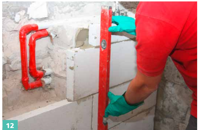
Die Ausrichtung der Steine in der Lot- und Waagerechten regelmäßig mittels Wasserwaage überprüfen.
