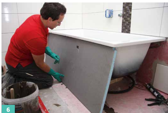
6 Die Platte einsetzen und mittels Wasserwaage ausrichten.
