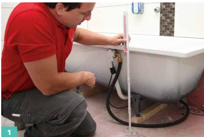
Den zu verkleidenden Bereich genau ausmessen ...
