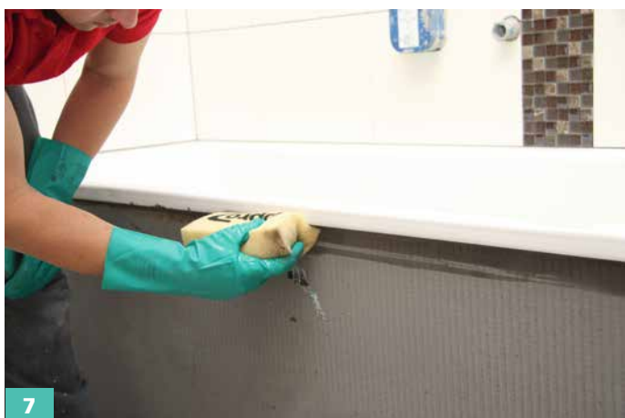
7 Überschüssigen Kleber mit der Kelle abstreichen oder mit einem Schwamm sauber abwaschen.
