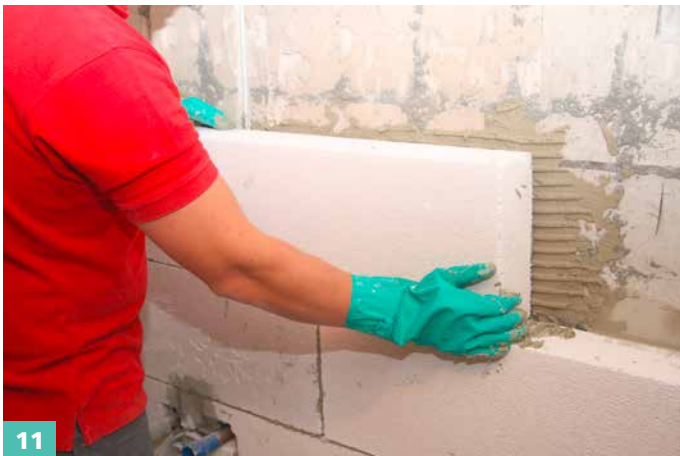
Um ungewollte Brüche zu vermeiden, die Steine im Verband setzen.
