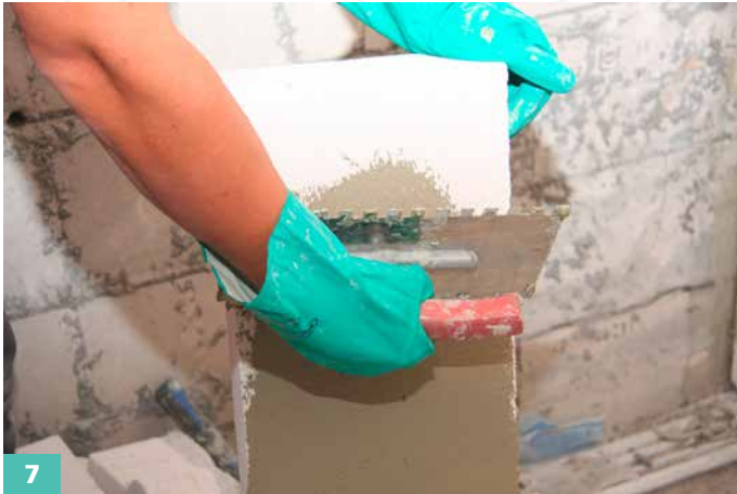
Auf die Rückseite des Steins eine Kontaktschicht aufziehen.
