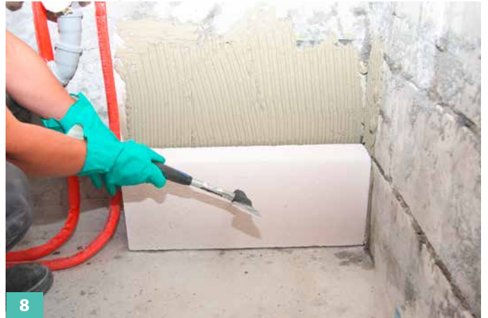
Den Stein in das vorbereitete Kleberbett einsetzen und durch Anklopfen justieren.
