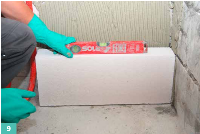
Die Ebenflächigkeit mittels Wasserwaage kontrollieren.
