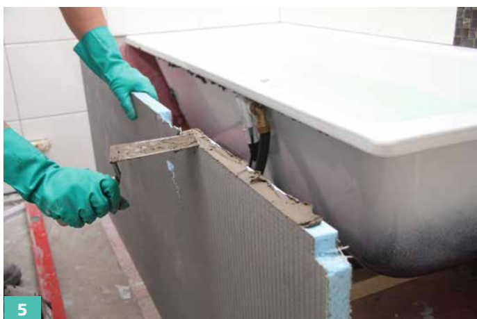
5 ... sowie auf die Platte selbst auftragen.
